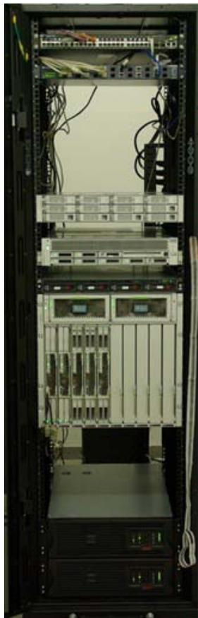
← Power Connect3548(スイッチングハブ)48ポートの10/100BASE-Tと2ポートの1000BASE-Tを搭載
